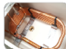
Echangeur tubulaire
